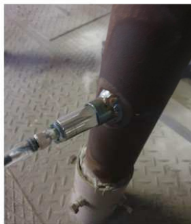
Obrázek 5: Umístění čidla v sile na vyrobené zrno
